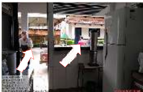
Figura 21- Janela e porta da cozinha sem tela milimétrica.
