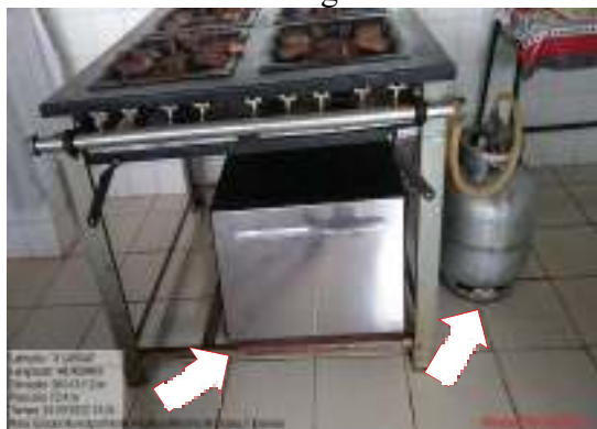
Figura 26– Botijão de gás acondicionado dentro da cozinha e fogão oxidado.
