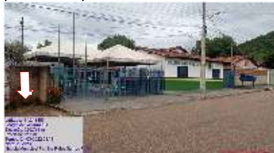
Figura 18 – Ausência de estacionamentos para PNE e para idosos.
